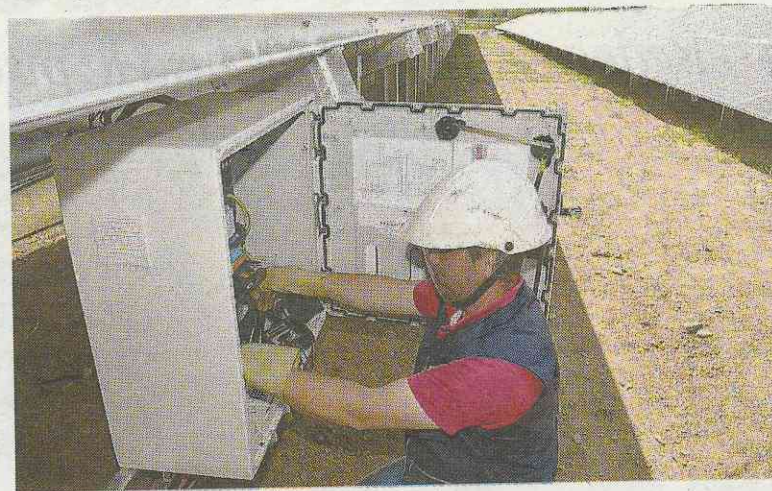
STRUTTURA Gli operai alle prese con le ultime installazioni (Spinolo)
