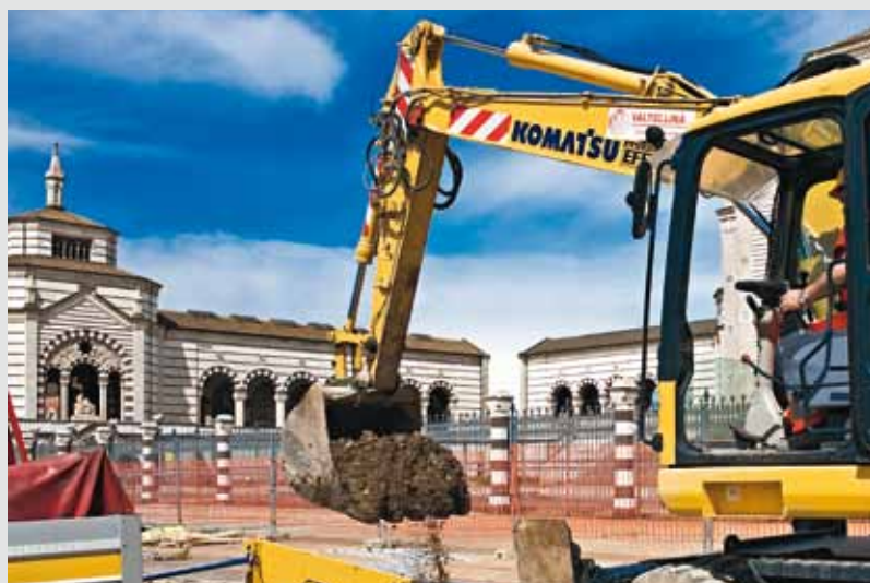
Il cantiere in area Monumentale a Milano
